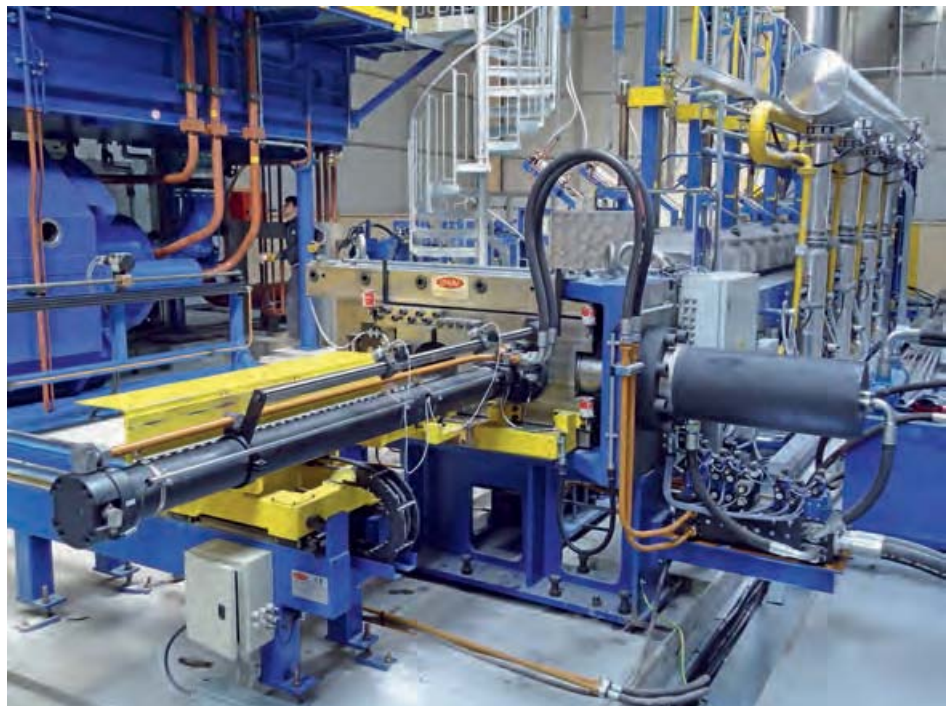
Warmsschere hinter dem Gaserwärmungs-ofen
