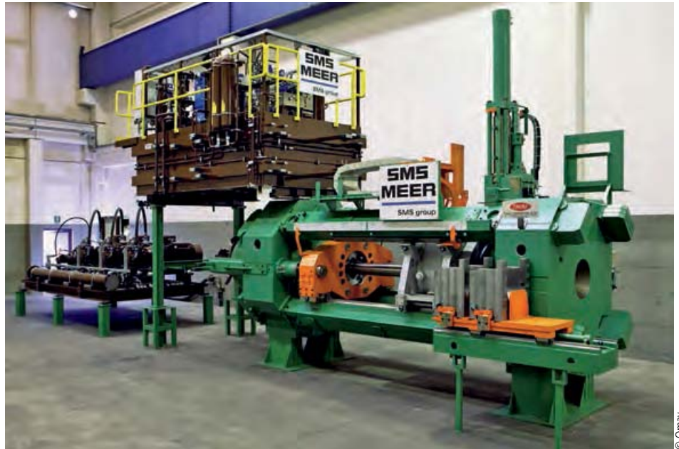
Montage der 22-MN-Strangpresse für Aluar im Omav-Werk in Rodengo Saiano
