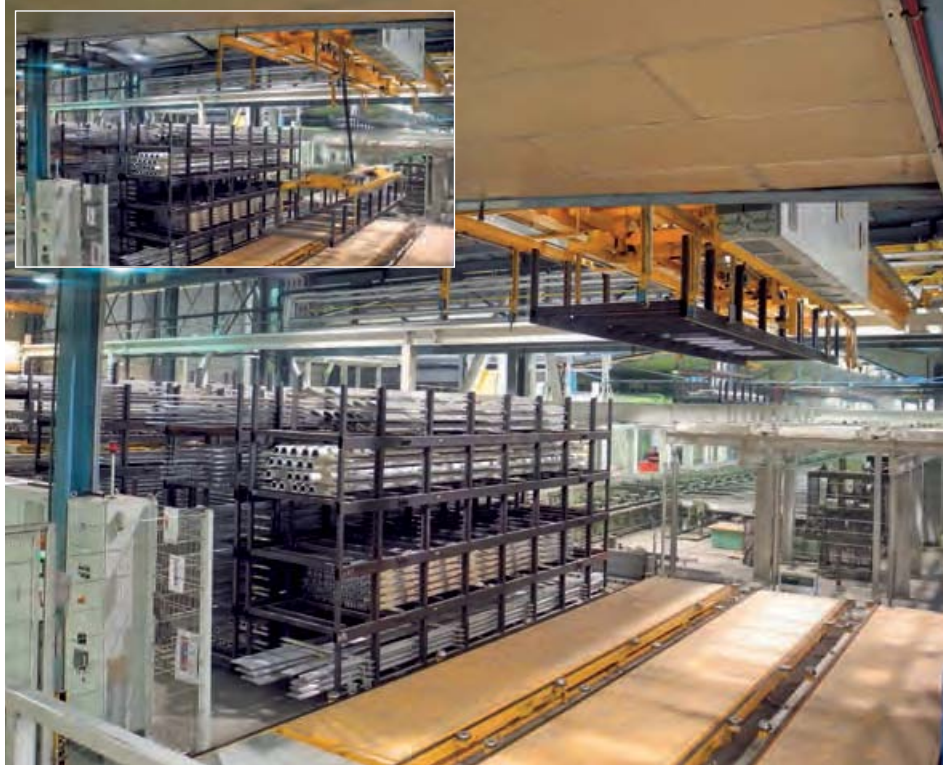
Übergabestation, die die neue Presse mit den bestehenden Pressen verbindet
